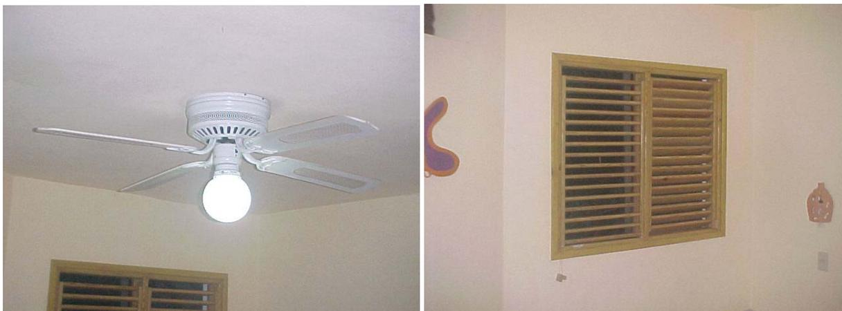
Abbildung 10: Deckenventilator mit Energiesparbeleuchtung sowie Holzlamellenfenster (Fotos: MÜLLER)
